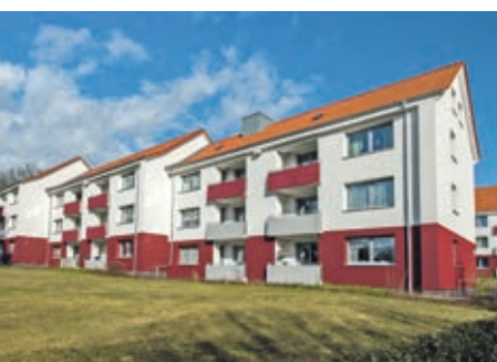
Am Fuhrenkamp heizt man seit Jahren mit Nahwärme.
