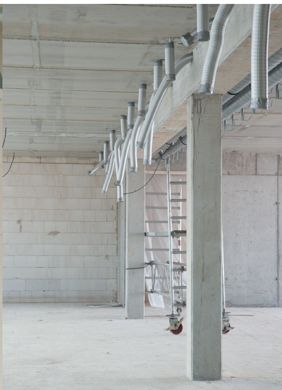
Die Räume sind in unterschiedliche Bereiche gegliedert, haben im engen Raster Zu- und Auslässe und bekommen die Luft automatisch optimal zugeteilt.
