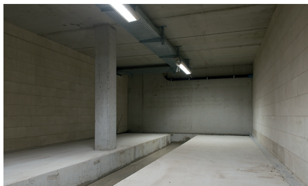
Versorgungsschacht im EDV-Raum: In Kürze werden von der Fa. Johann Osmers Kühlaggregate in die Serverräume montiert, um die Prozessoren gleichmäßig zu temperieren und deren Abwärme zum Heizen zu verwenden.
