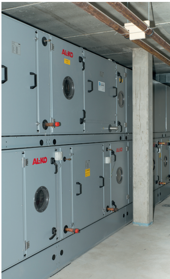
Kombiniertes Zu- und Abluftgerät 11.000 m³/h von AL-KO-THERM
