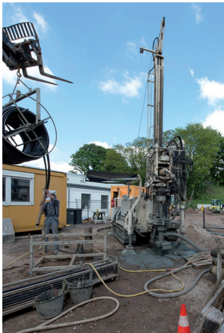
Erdbohrungen zum Einbau der Erdwärmesonden
