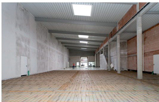
Montage Fußbodenheizung Werkhalle
