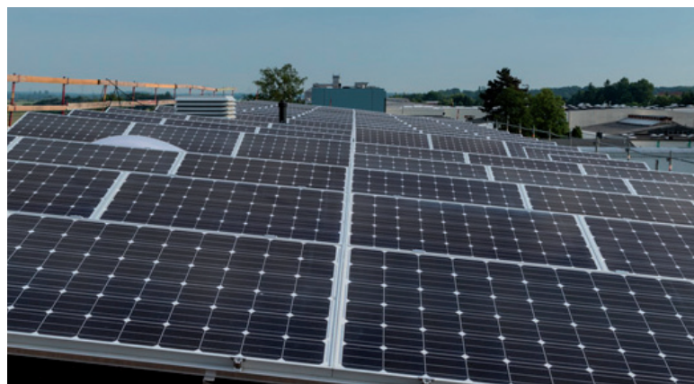
Auf einer Dachfläche von rund 600 qm wurde eine Photovoltaikanlage installiert, Leistung: ca. 28 KW/peak.
