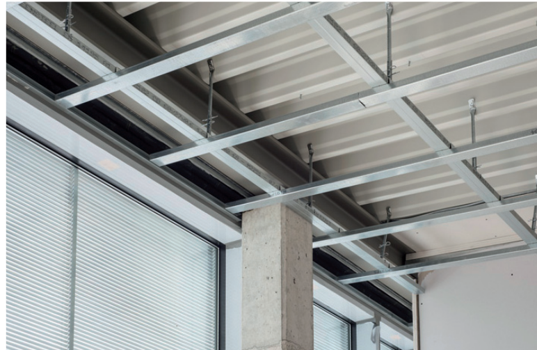
Unterkonstruktionen für Heiz-/Kühldecke
