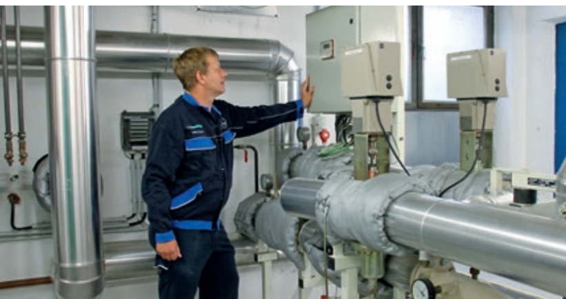
Stadtwerke-Monteur Hubert Wend überprüft die Nahwärme-Übergabestation im Verwell.
