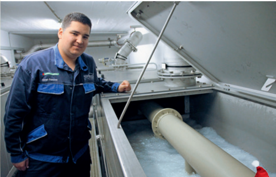
Natürliches Verfahren: Stadtwerke-Auszubildender Sinan Basaran am neuen Flachbettbelüfter.
