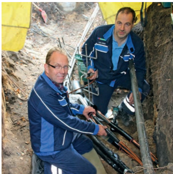
Frank Dreyer (l.) und Lars Müller verlegen ein Mittelspannungskabel.
