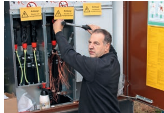
Stadtwerke-Monteur Lars Müller schließt ein Neubaugebiet ans Stromnetz an.
