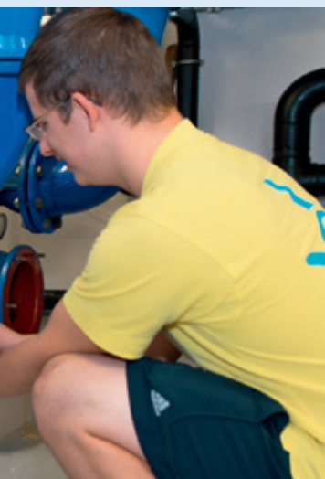
Immer sauberes Wasser – Sascha Hogrefe überprüft das Filtersieb der Umwälzpumpe.
